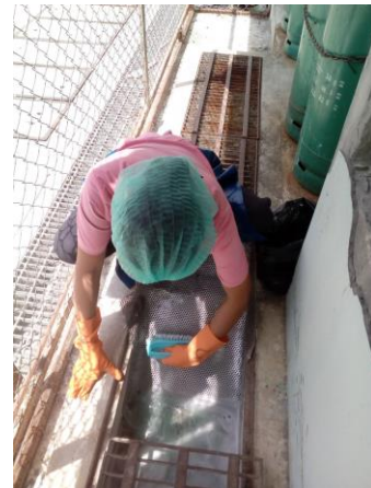
รูปที่ 2-16 ติดตั้งตะแกรงดักขยะที่บ่อพัก (สุดท้าย)
